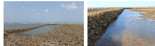
(左)圖 14 蚵間 1 號石滬於 2020 年修復完成
