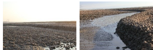
(右)圖 15 蚵間 5 號石滬於 2021 年 7 月修復完成
