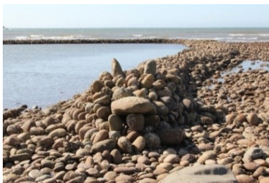
圖 21 深圳 1 號石滬 2021 年修復完成並於部分滬堤進行造型變化
