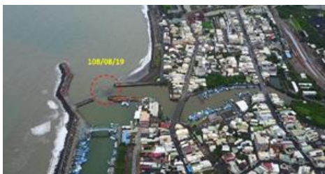
圖 1 枋寮漁港 108 年港口淤積情形
